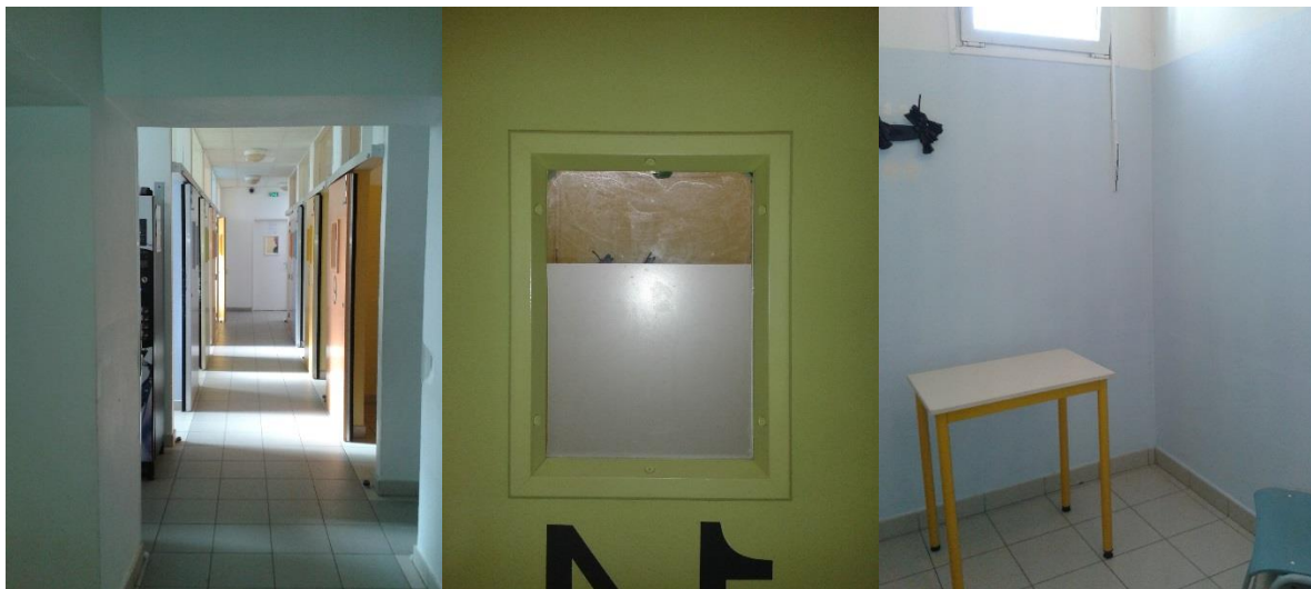
Couloir d'accès aux boxes(au fond la porte d'entrée des personnes détenues), porte d'un parloir, intérieur d'un parloir
