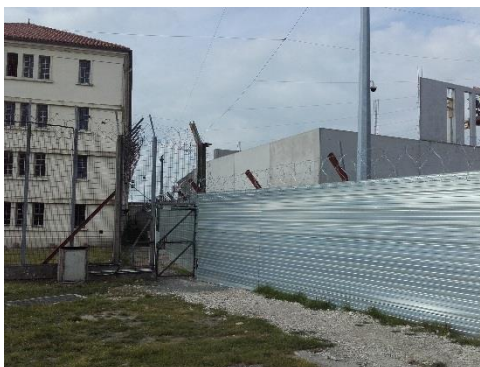
Vue sur le gymnase en construction
