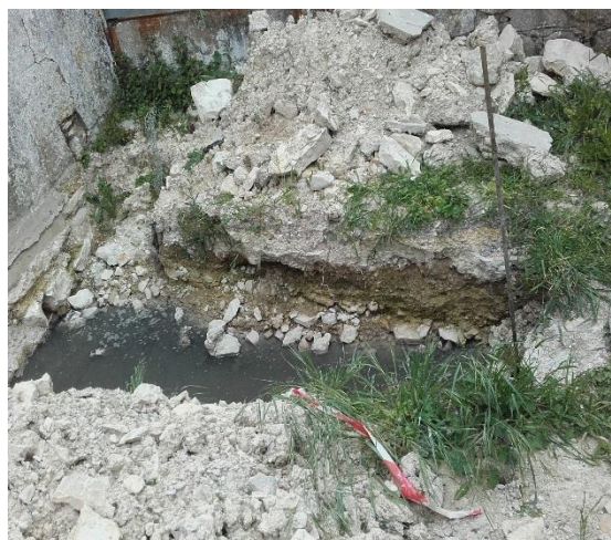
Mauvaise évacuation des eaux sales de la cuisine dégageant des odeurs nauséabondes
