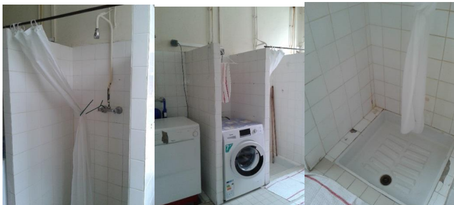
Vue sur partie du local sanitaire et une douche
