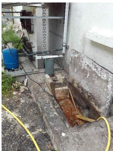
Mauvaise évacuation des eaux sales de la cuisine dégageant des odeurs nauséabondes
